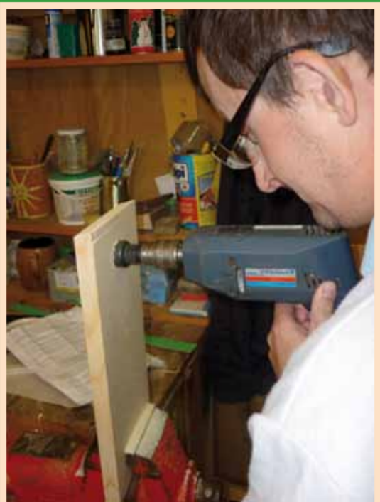
Vyvrátíme otvor k vletu. Velikost viz tabulka.
