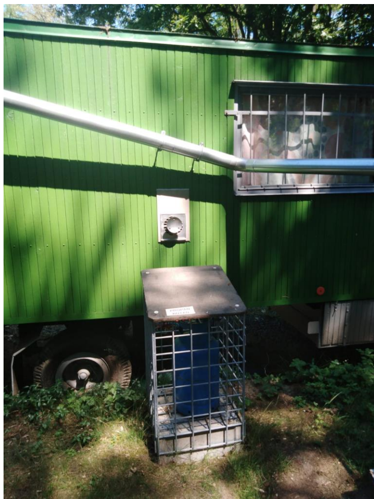
Vytápění zajištěno plynovou bombou
